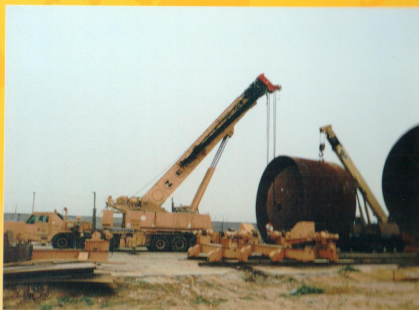
• جابجایی و نصب: قطعات تاور اهواز
