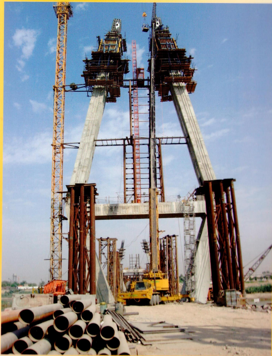
• نصب پاكسهای كابل پل هشتم اهواز
