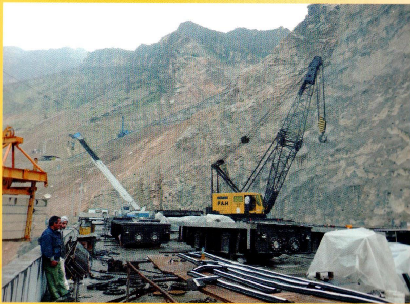
• سد کارون ۴ نصب دریچه های اضطراری در عمق ۷۰ متری (سال ۱۳۸۸)
