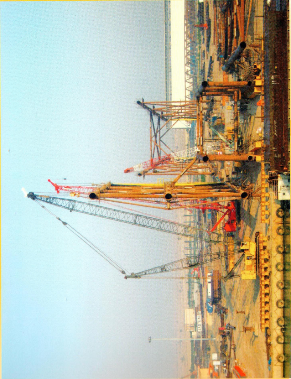
ساخت جاکت JACKET و عرشه DECK
